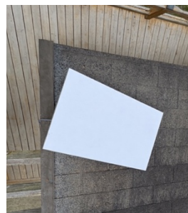
▲休憩舎の屋根に整備した Starlink 衛星アンテナ※ ※本アンテナは、衛星との通信品質を最適化するため、 衛星の位置に合わせて適切な角度で設置しています。
