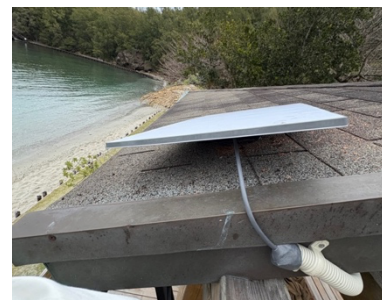
▲休憩舎の屋根に整備した Starlink 衛星アンテナ※ ※本アンテナは、衛星との通信品質を最適化するため、 衛星の位置に合わせて適切な角度で設置しています。
